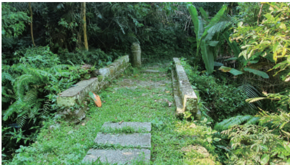
茶亭古道糯米橋
