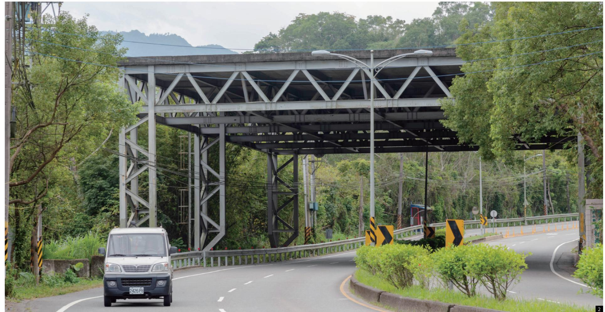
1. 跨越橋通常出現在「地塹」路段。2. 橫山鄉 66.9k 處有一座桁架搭建的平台，像是個大雨庇般，經過時彷彿通過一座明隧道。
